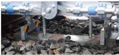
既設のPCまくらぎに対して、2穴同時穿孔が可能で、PCまくらぎ内の鋼線に干渉なく、短時間で精度の高い穿孔が行えます
